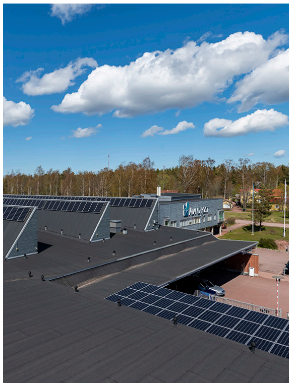
Taket på Sviby Postterminal med 420 solpaneler.
